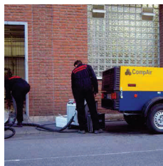
Czyszczenie suchym lodem
